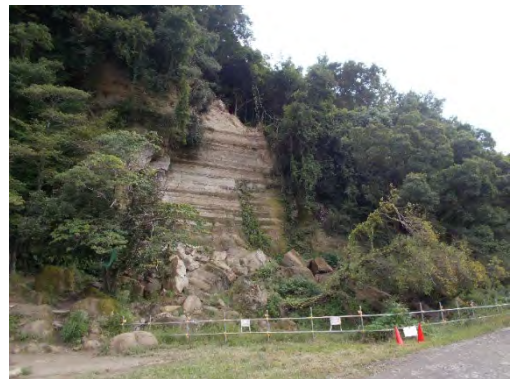
写真 1.No.25 神沢・滝の崖崩落
