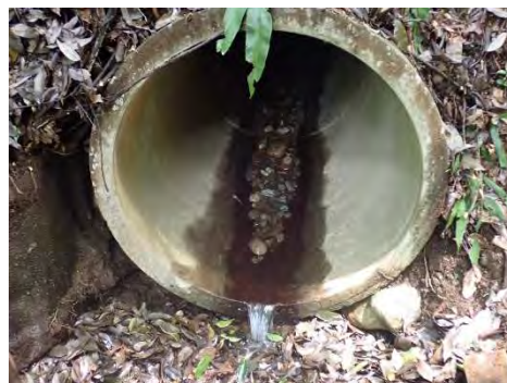
写真 1. N5 の湧水口の土管
