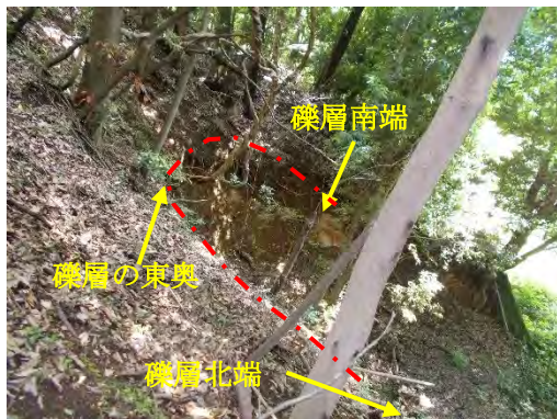
写真 4.露頭頂面の横から露頭と急斜面
